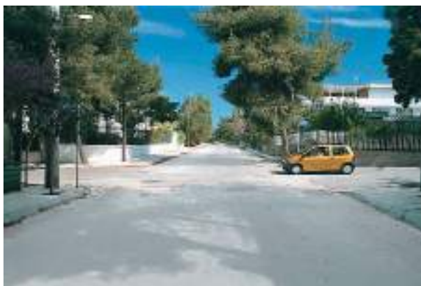
Σχ. 3.6 Διασταύρωση χωρίς σήμανση.
